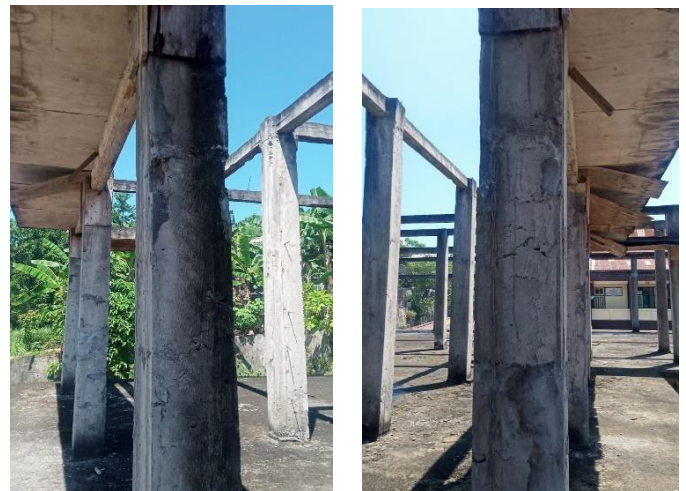
Gambar Kondisi Eksisting Kolom Pembangunan Gedung Belajar Universitas Nuku
